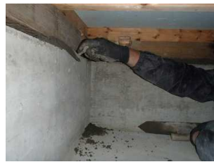
復旧工 (土台下モルタル詰め状況)
