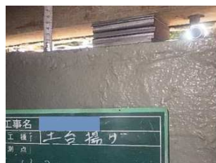
ジャッキアップ工(ライナー設置完了)
