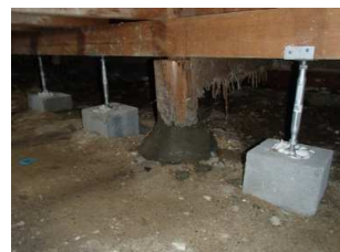
基礎モルタル補修完了
