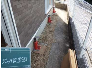
ジャッキアップ準備工 (外周ジャッキ設置完了)
