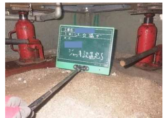
ジャッキアップ準備工(床下ジャッキ設置完了)
