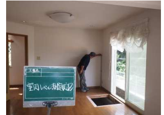
ジャッキアップ工 (測量状況)
