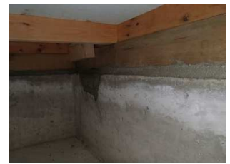
復旧工 (土台下モルタル詰め完了)
