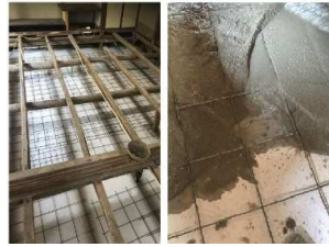
床下土間工(メッシュ筋設置、生コンクリート打設状況)
