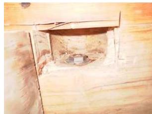
復旧工 (アンカーボルト締め付け完了)
