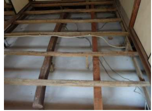
床下土間工(生コンクリート打設完了)
