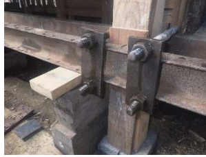
ジャッキアップ準備工(柱固定完了)
