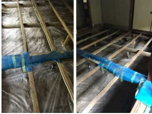
床下土間工(防湿シート布設完了)
