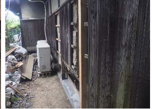
復旧工(外周基礎補修)
