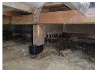
ライナー設置完了
