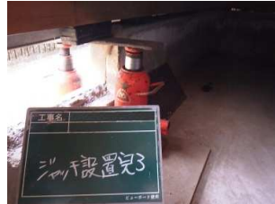
ジャッキアップ準備工 (床下ジャッキ設置完了)
