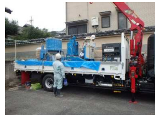
車上プラント 全景
