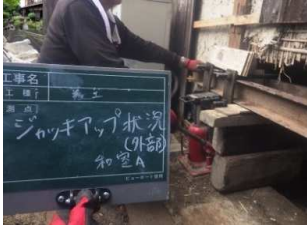
ジャッキアップ工(ジャッキアップ状況)
