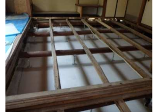
復旧工(鋼製束設置完了)
