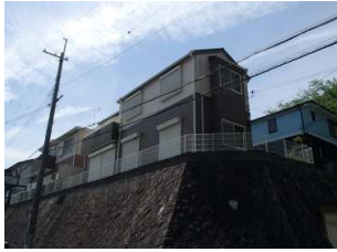
着工 (家屋全景)
