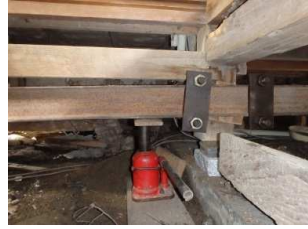
ジャッキアップ準備工(ジャッキ設置完了)
