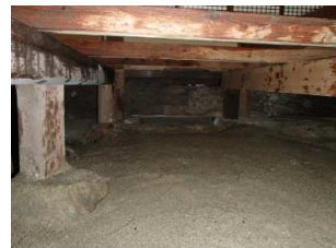
注入完了、整地
