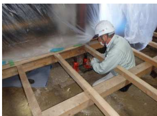
ジャッキアップ状況
