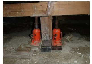
ジャッキ設置完了
