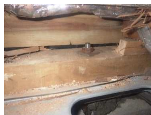
復旧工(アンカーボルト締め付け完了)
