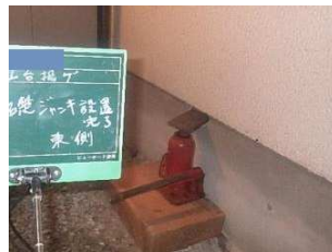
ジャッキアップ準備工(外部ジャッキ設置完了)
