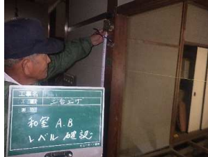
ジャッキアップ工(測量状況)
