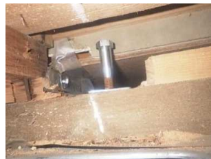
ジャッキアップ準備工(アンカーボルト解放、延長状況)
