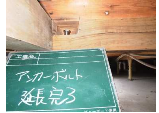
ジャッキアップ準備工 (アンカーボルト延長完了)
