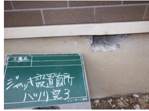
ジャッキアップ準備工 (ジャッキ設置箇所ハツリ完了)
