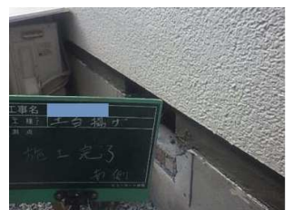
復旧工(モルタル詰め完了)
