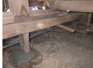
ジャッキアップ工(ジャッキアップ完了)
