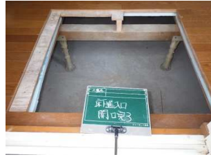
準備工 (床下進入口開口完了)
