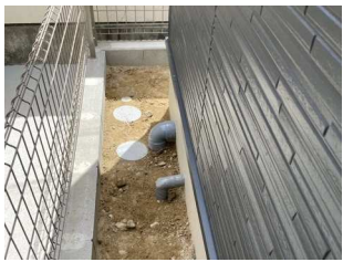
(施工後 配管復旧)
