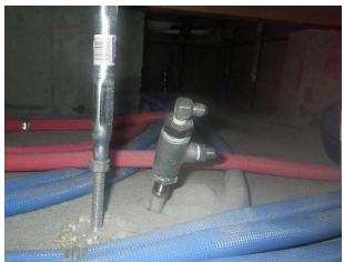
(注入管建て込み状況)
