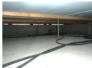
(注入状況 床下)
