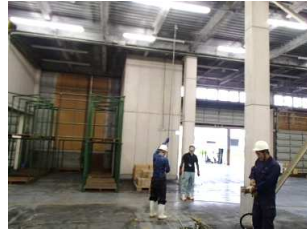
注入管建込み
