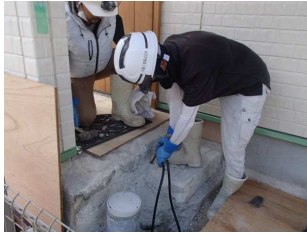
(注入管建て込み)
