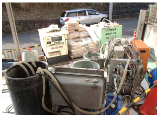
(注入状況 プラント)
