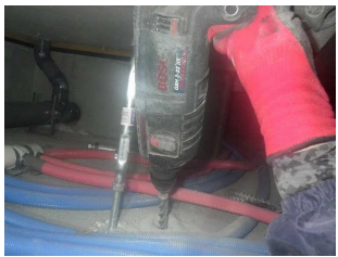
(床下削孔状況)
