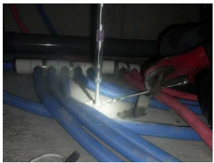
(床下削孔箇所復旧状況)
