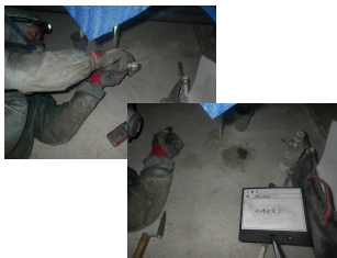
(注入管撤去、注入孔復旧)
