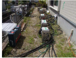
(配線、配管接続)
