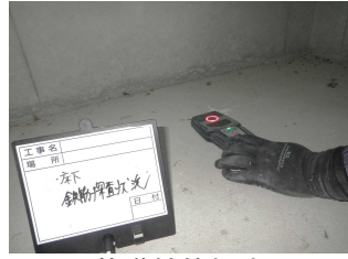
(基礎鉄筋探査)
