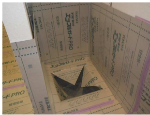
(室内養生状況)
