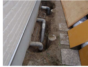
(排水管ジャバラ設置、給水管フリー)
