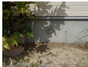
(横孔 丸形換気口設置)
