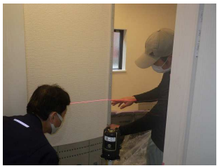
(室内計測状況)
