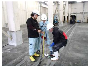
注入管ステップアップ
