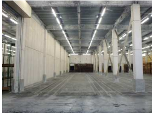
施工建物 (建物内)
