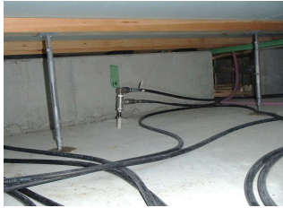
(注入管建て込み、配線)
