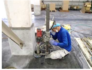
削孔状況 (湿式コアドリル \phi 40mm)
