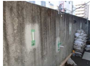
ジャッキアップ工 (傾斜計測状況)
