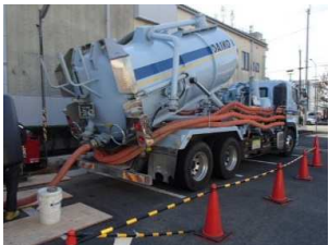
空隙充填工 (流動化処理土搬入)
