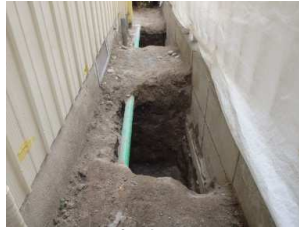
掘削工 (外周ポイント掘削)
