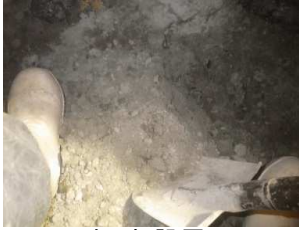
耐圧版設置工 (耐圧版下セメント改良)
