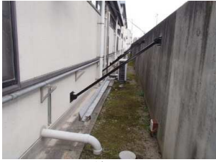
着工 (コンクリート塀全景)
