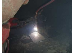
耐圧版設置工 (リブ溶接状況)
