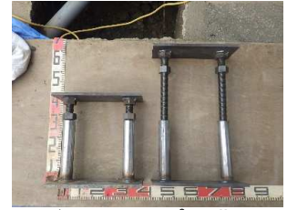
ジャッキアップ準備工 (材料検収 支持台)
