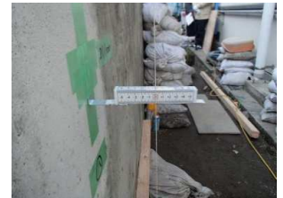
ジャッキアップ工 (傾斜計測状況)
