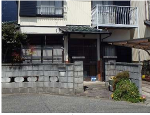
着工 (建物正面)
