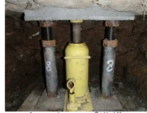
ジャッキアップ準備工 (支持台、ジャッキ設置)
