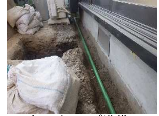
ジャッキアップ準備工 (埋設管配管出し)
