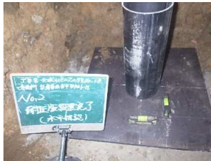
耐圧版設置工 (耐圧版設置完了)
