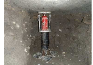
ジャッキアップ準備工 (支持台設置、ジャッキセット)
