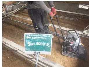
埋め戻し工 (埋め戻し、転圧状況)
