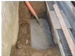
空隙充填工 (流動化処理土打設状況)
