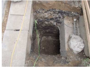
掘削工 (進入口掘り下げ完了)
