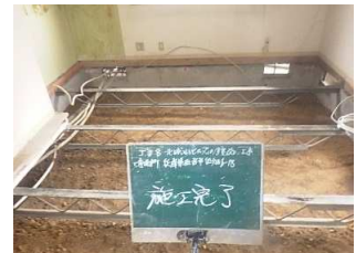
完工 (床下全景)
