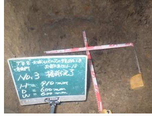
掘削工 (掘り下げ完了)
