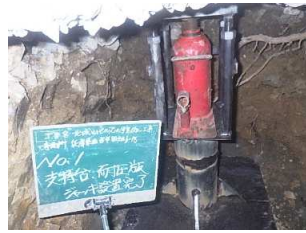
ジャッキアップ準備工 (支持台、ジャッキ設置完了)
