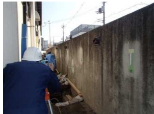
ジャッキアップ工 (レベル計測状況)
