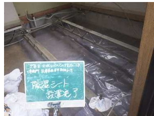
復旧工 (床下防湿シート設置状況)
