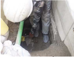
ジャッキアップ工 (ジャッキアップ状況)
