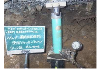
鋼管圧入工 (加圧状況)
