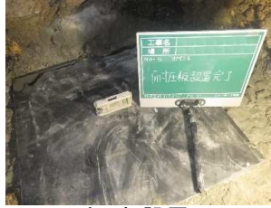
耐圧版設置工 (耐圧版設置)
