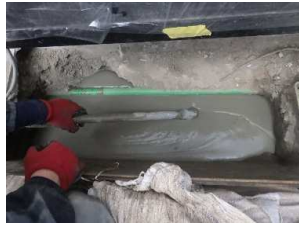
空隙充填工 (エアームルク打設状況)
