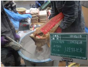
空隙充填工 (エアームルク攪拌状況)
