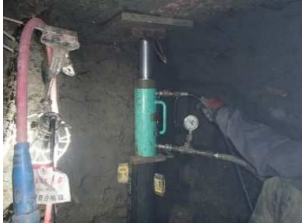
鋼管杭圧入工 (圧入状況)
