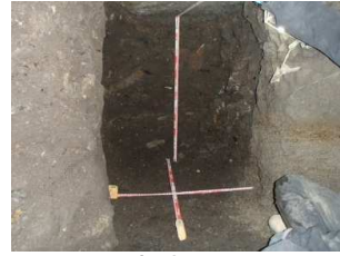
掘削工 (ポイント掘削完了)
