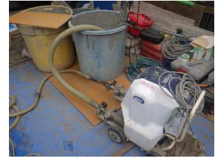
空隙充填工 (プラント全景)
