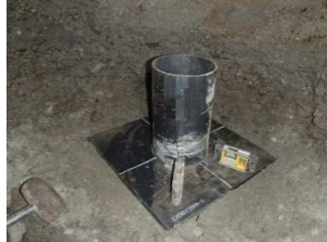
耐圧版設置工 (設置状況)
