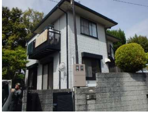
着工 (家屋全景)
