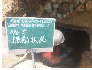
掘削工 (トンネル掘削状況)
