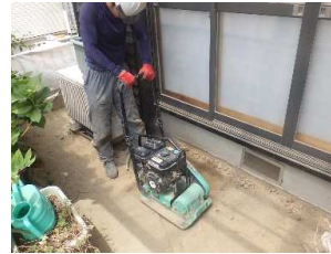
復旧工 (埋戻し、整地状況)
