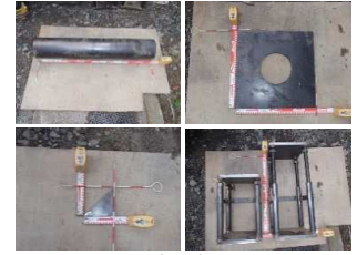
材料検収 (鋼管杭、耐圧版、リブ、支持台)
