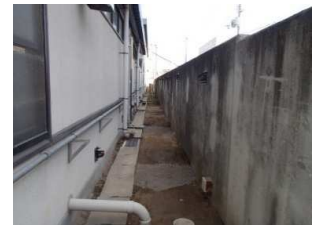
完工 (コンクリート塀全景)
