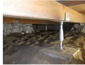
復旧工 (鋼製束交換)
