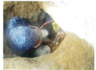
ジャッキアップ準備工(治具取り付け)
