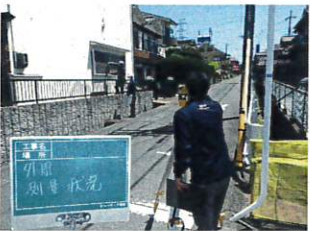
ジャッキアップ工(レベル確認状況)
