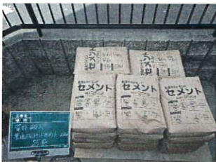
空隙充填工(普通ポルトランドセメント資材搬入)
