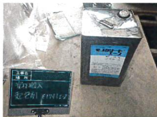
空隙充填工(モノクリートエース資材搬入)
