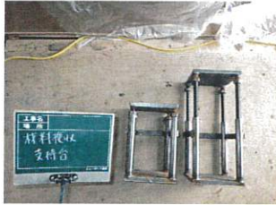
ジャッキアップ準備工(支持台材料検収)
