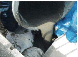
空隙充填工(エアミルク打設状況)
