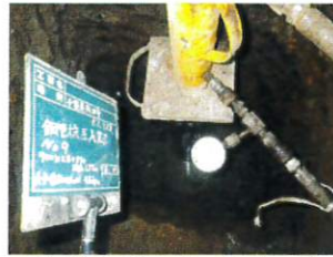
鋼管圧入工(圧入完了)
