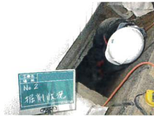
掘削工(掘削状況)
