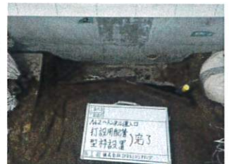
埋戻し工(埋戻し、型枠設置完了)
