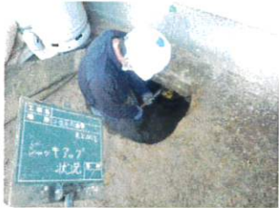
ジャッキアップ工(ジャッキアップ)
