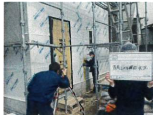
ジャッキアップ工(レベル確認状況)
