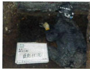
掘削工(掘削状況)
