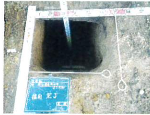
掘削工(掘削完了)
