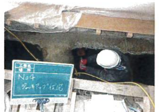
ジャッキアップ工(ジャッキアップ)
