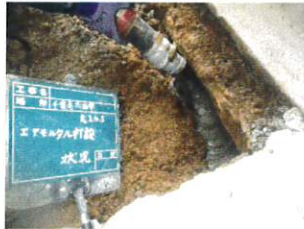
空隙充填工(エアモルタル打設)
