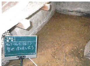
埋戻し工(整地完了)
