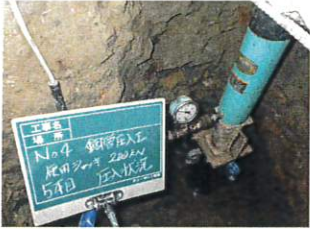
鋼管杭圧入工(鋼管圧入状況)
