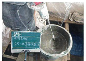
空隙充填工(エアミルク攪拌状況)
