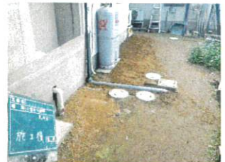
復旧工(整地完了)
