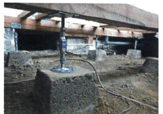
復旧工(束交換)
