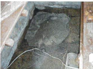
空隙充填工(エアミルク打設完了)
