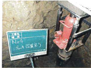
ジャッキアップ準備工(支持台設置、ジャッキセット完了)
