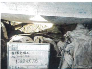
空隙充填工(エアミルク打設状況)
