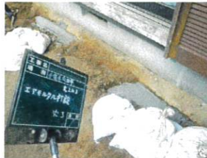
空隙充填工(エアモルタル打設完了)
