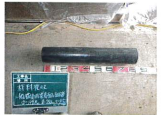
鋼管杭圧入工(鋼管材料検収)
