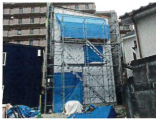
建物正面全景
