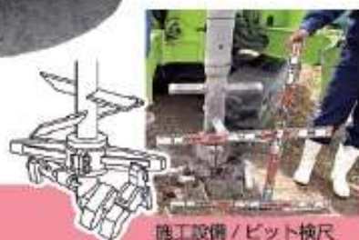
施工設備 / ビット検尺
