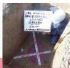
拡張部杭径確認
